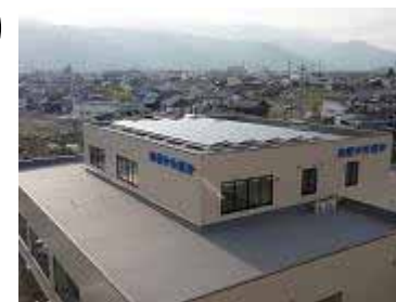
太陽光発電装置の設置
