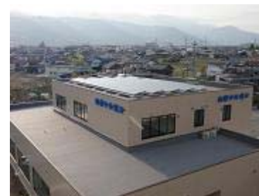
太陽光発電装置の設置
