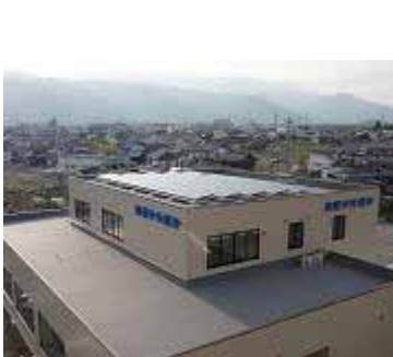
太陽光発電装置の設置
