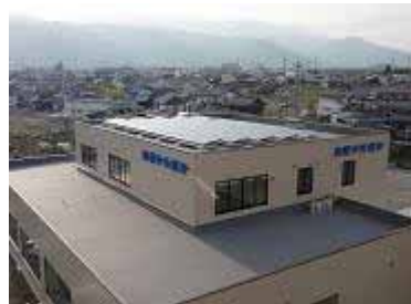
太陽光発電装置の設置
