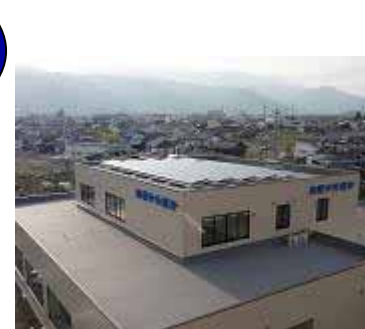
太陽光発電装置の設置
