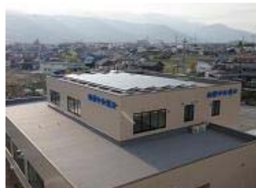
太陽光発電装置の設置
