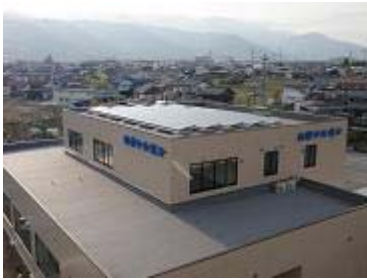
太陽光発電装置の設置
