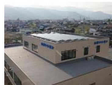
太陽光発電装置の設置
