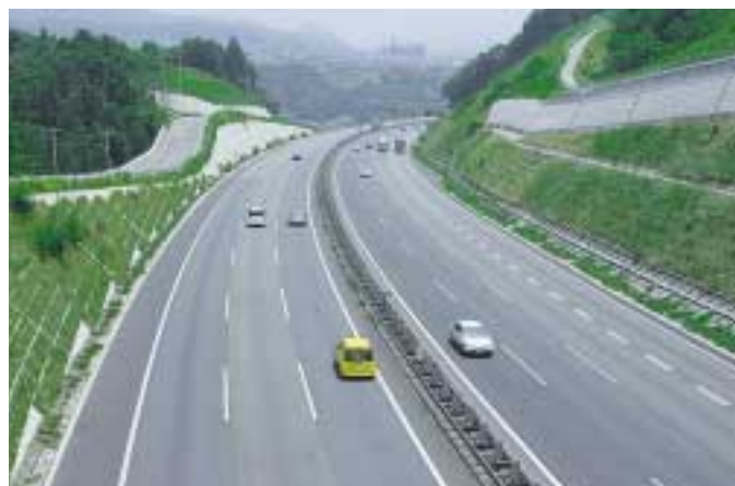
中央自動車道6車線化
