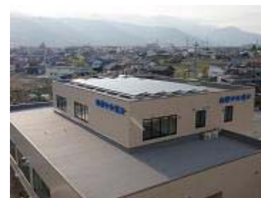
太陽光発電装置の設置
