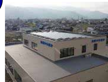
太陽光発電装置の設置
